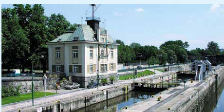
plavební komora Štvanice
