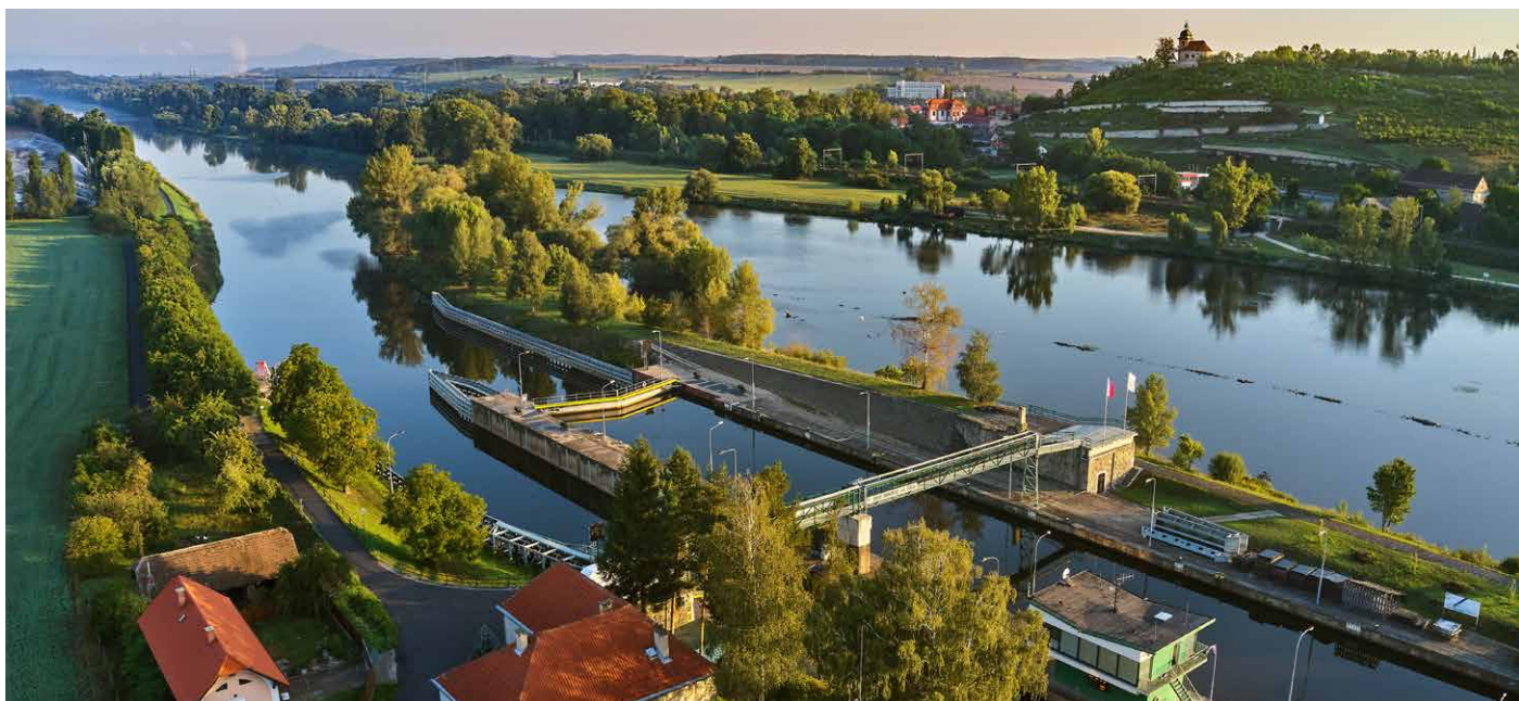
Plavební komora Dolní Beřkovic
