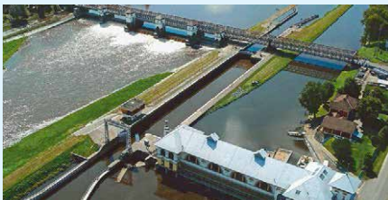
plavební komora Miřejovice
